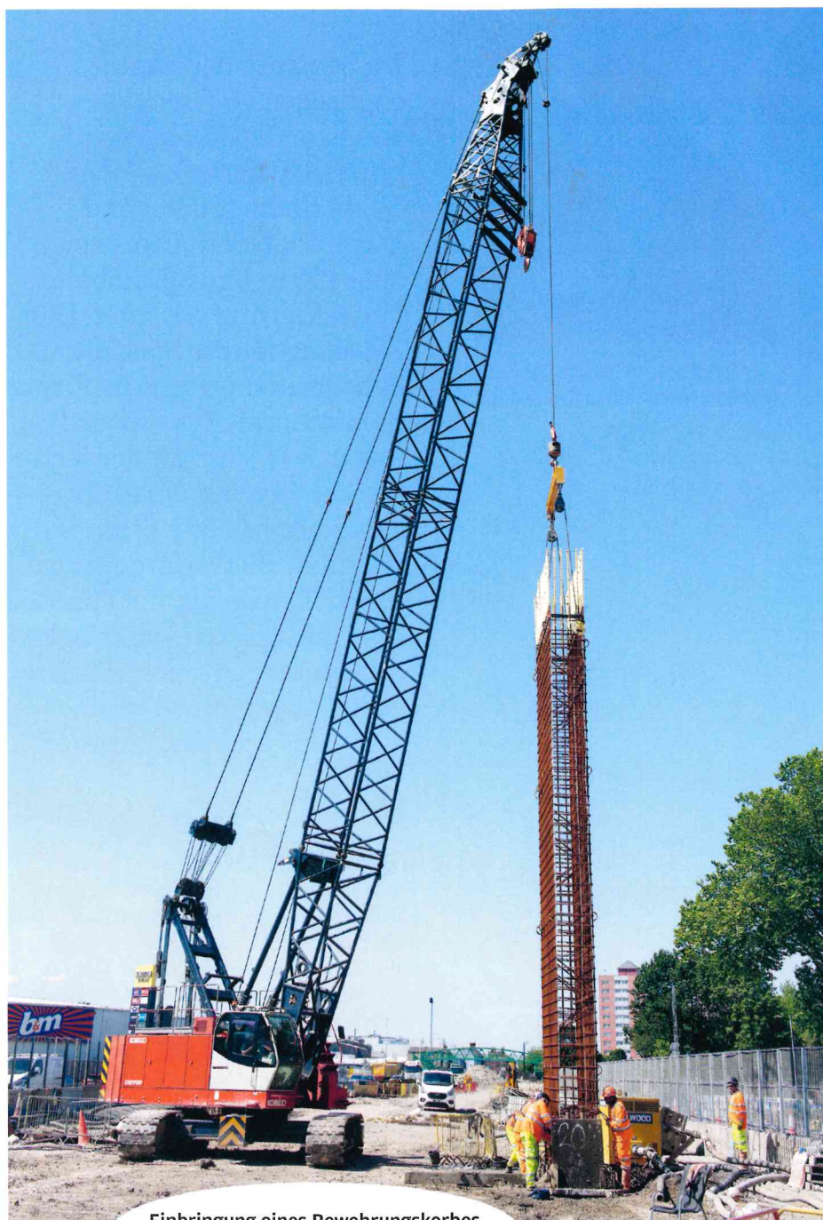
Einbringung eines Bewehrungskorbes in eine der Schlitzwände.
