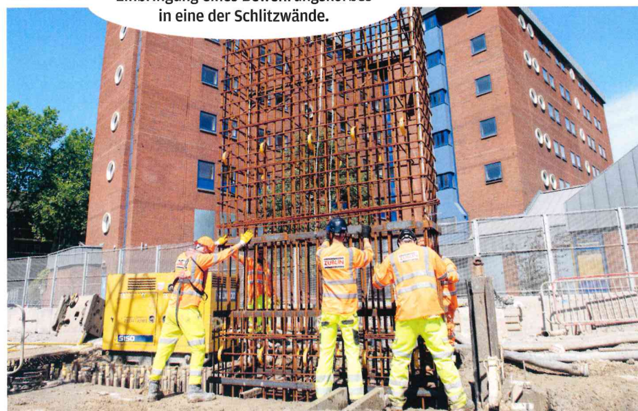
Einbringung eines Bewehrungskorbes in eine der Schlitzwände.
